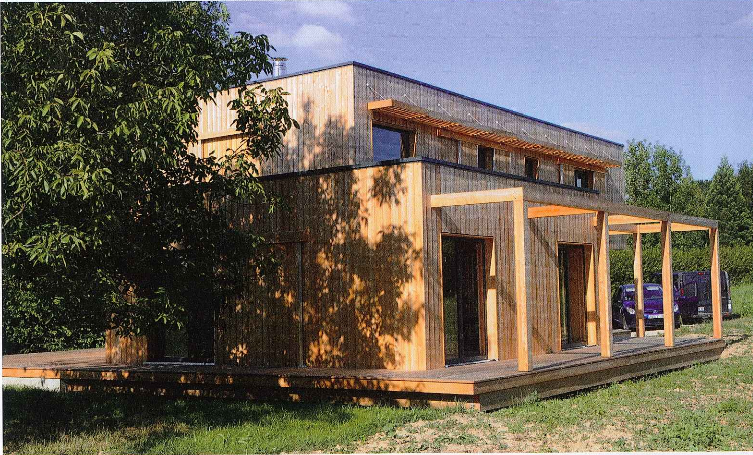
Protections solaires. La structure de pergola, au rez-de-chaussée, et le brise-soleil au-dessus de la terrasse, à l'étage, protègent la maison du soleil de l'été.
