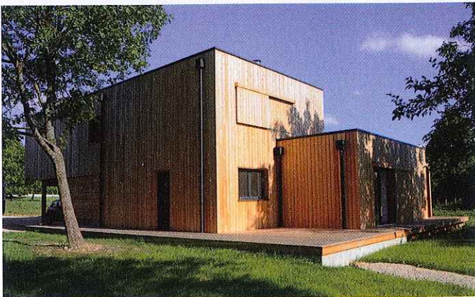
La façade nord n'est percée que par la porte d'entrée. On note les descentes d'eau de pluie qui alimentent une cuve de 3 000 litres pour les WC et le lave-linge.
