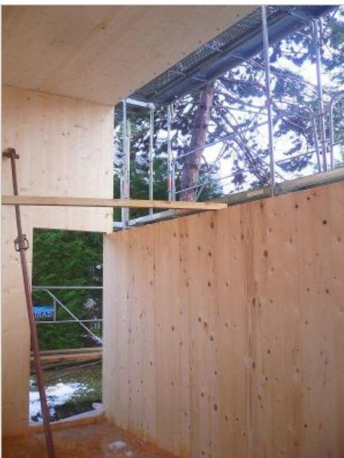
Le choix du système constructif a permis de réaliser un chantier à faibles nuisances : les fondations par micropieux ont été réalisées à l'aide de tiges métalliques avec un minimum d'impact sur le terrain en seulement trois jours. De même, la structure réalisée en bois massif (système préfabriqué KLH) a été montée en seulement 4 jours pour 275 m<sup>2</sup>. En tout, trois semaines seulement auront été nécessaires.
